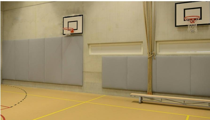
Diese Wandpaneele sind wie folgt aufgebaut: Das Basispaneel ist ein 12mm brandschutzsicheres MDF Firax. Darauf werden MDF-Ränder mit einem abgerundeten Rand befestigt, wodurch die Paneele keine scharfen harten Kanten haben. Für die Geräuschabsorption sorgt recycelte Baumwolle (ausgemusterte Jeans). Für die Polsterung werden zwei Stoffe verwendet. Das erste Tuch ist eine stabile Unterschicht, die dem Product seine mechanische Stärke verleiht. Der sichtbare Stoff wird über diesen Stoff gezogen
